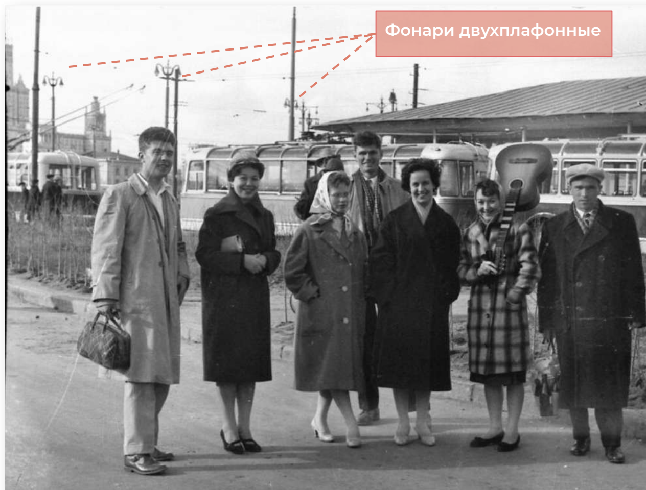
Южный наземный вестибюль метро «Университет» 1960-е гг.
